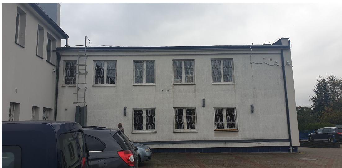
Widok wschodniej ściany budynku
