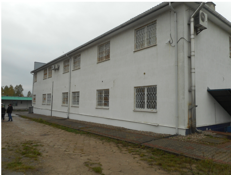
Widok południowej ściany budynku
