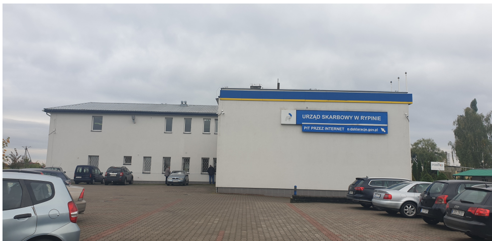
Widok północnej ściany budynku
