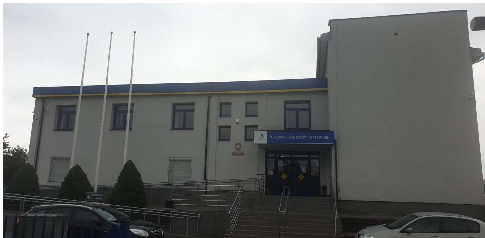
Widok zachodniej ściany budynku
