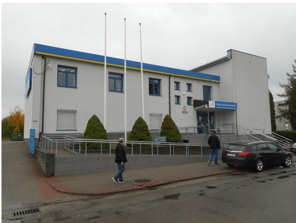
Widok zachodniej ściany budynku
