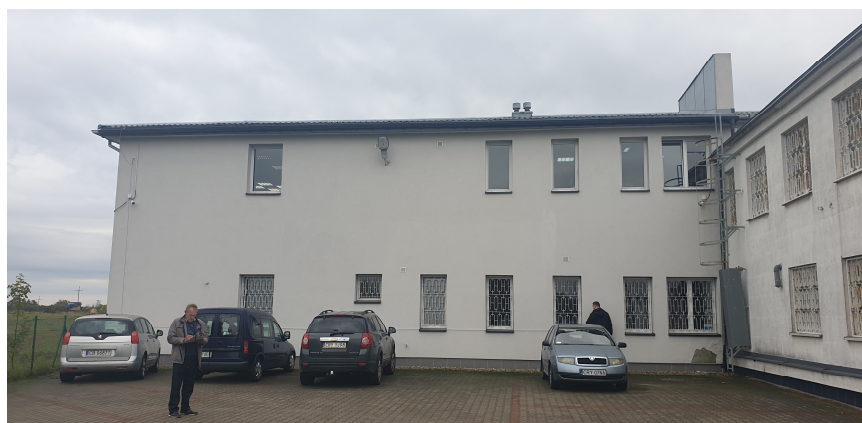
Widok północnej ściany budynku
