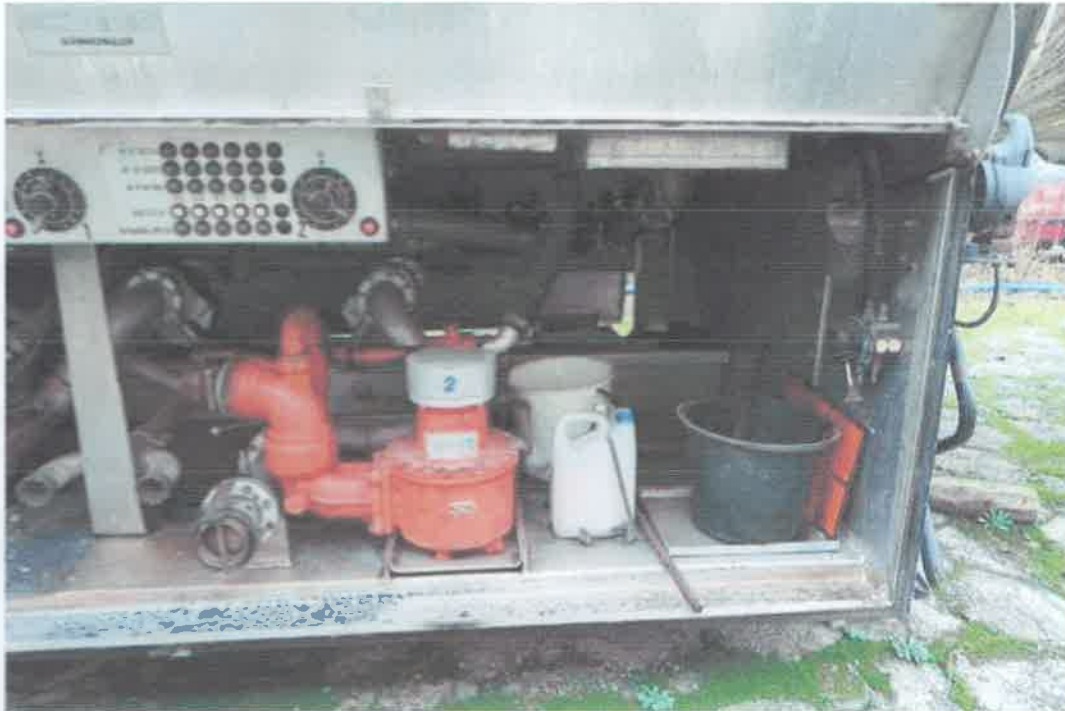
11 System dystrybucyjno - pomiarowy.
