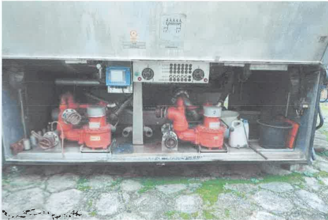
09 System dystrybucyjno - pomiarowy.
